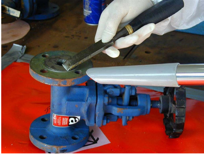
Abb. 11.6 Verwendung eines Staubsaugers, um den beim Ablösen von Asbest von einem Ventil entstehenden Staub unverzüglich einzufangen
