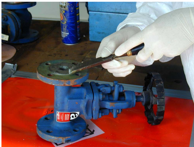
Abb. 11.5 Verwendung von Handwerkzeug, um Asbestdichtung und Asbestreste von einem Ventil abzulösen
