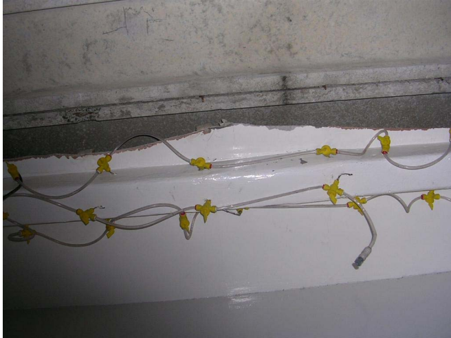
Abb. 12.10 Beispiel einer Mehr-Punkt-Injektion. Dieses System wird zum Benetzen von Spritzasbest verwendet.
