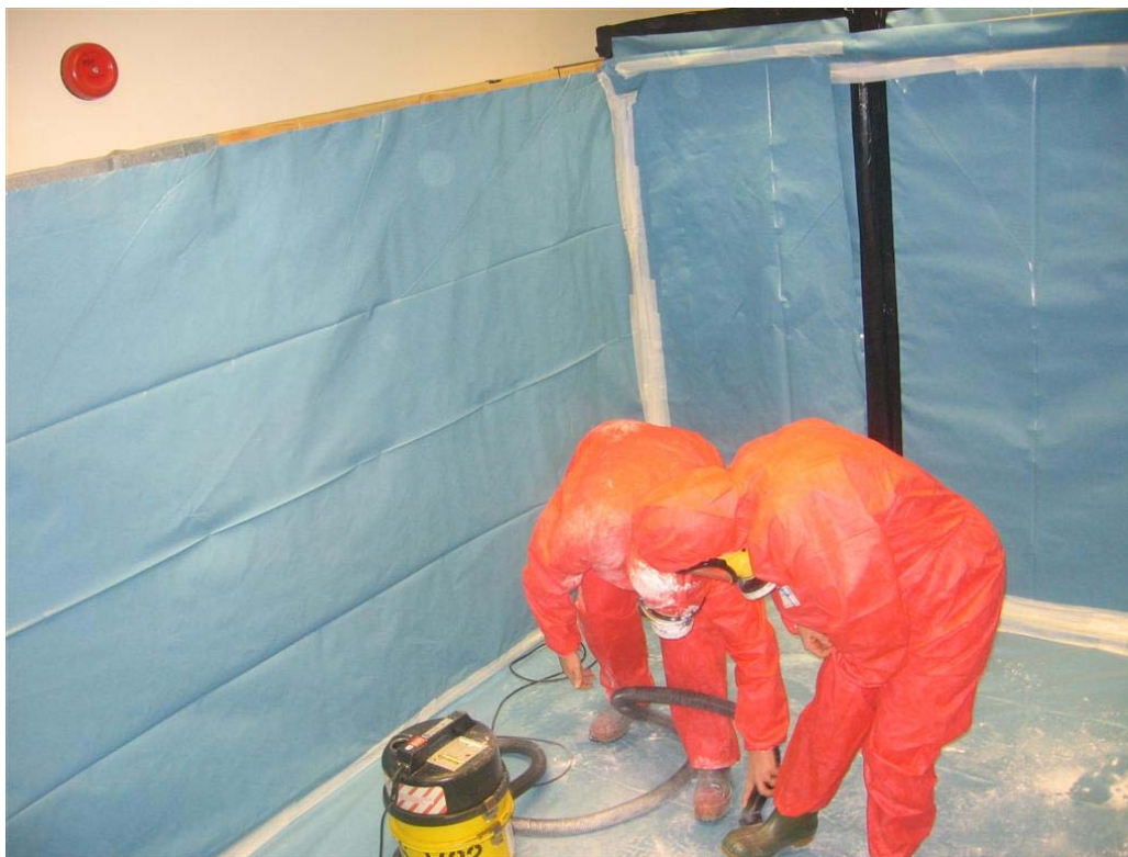
Abb. 7.1 Praktische Übung in der Verwendung eines H-Typ Staubsaugers, um simuliertes kontaminiertes Material (Talkpulver) zu entfernen. Diese Abbildung wurde von dem britischen HSE zur Verfügung gestellt.
