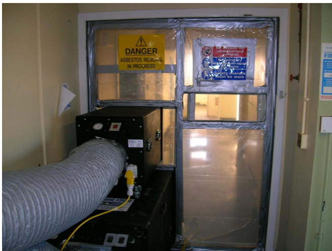
Abb. 12.2 Unterdruckeinheiten und Luftablassröhren, Sichtfenster und Warnhinweise
